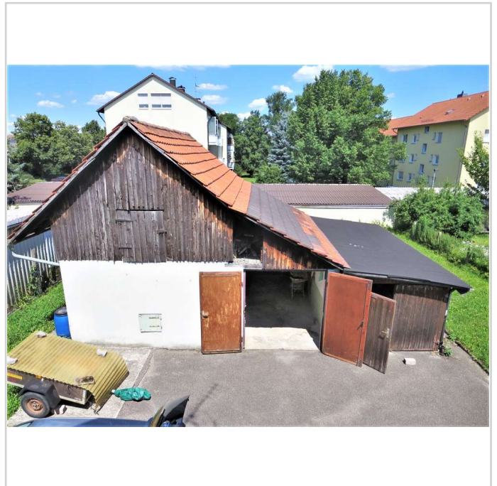
Scheune und Garage
