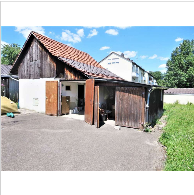
Scheune und Garage
